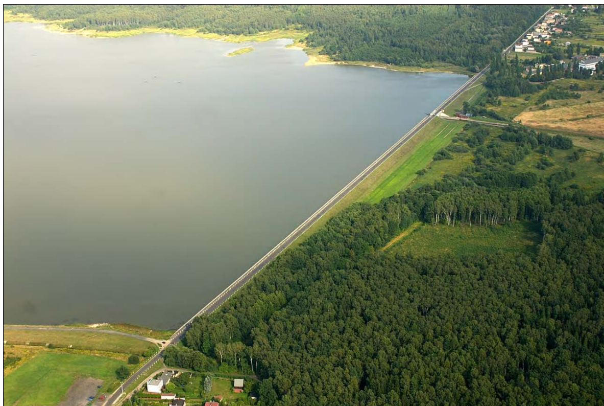
Fot. 2. Zbiornik Kozłowa Góra. Zapora czołowa
