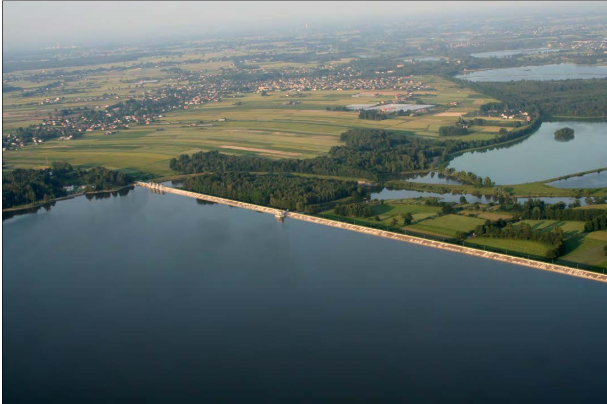
Fot. 1. Zbiornik Goczałkowice. Zapora czołowa
