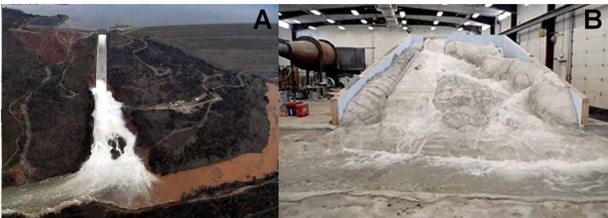
Ryc. 3. Zapora w Oroville (Kalifornia, USA); A – zdjęcie uszkodzonej zapory (Josh Edelson, afp.com ), B – zdjęcie modelu skonstruowanego na Uniwersytecie Stanowym w Utah
