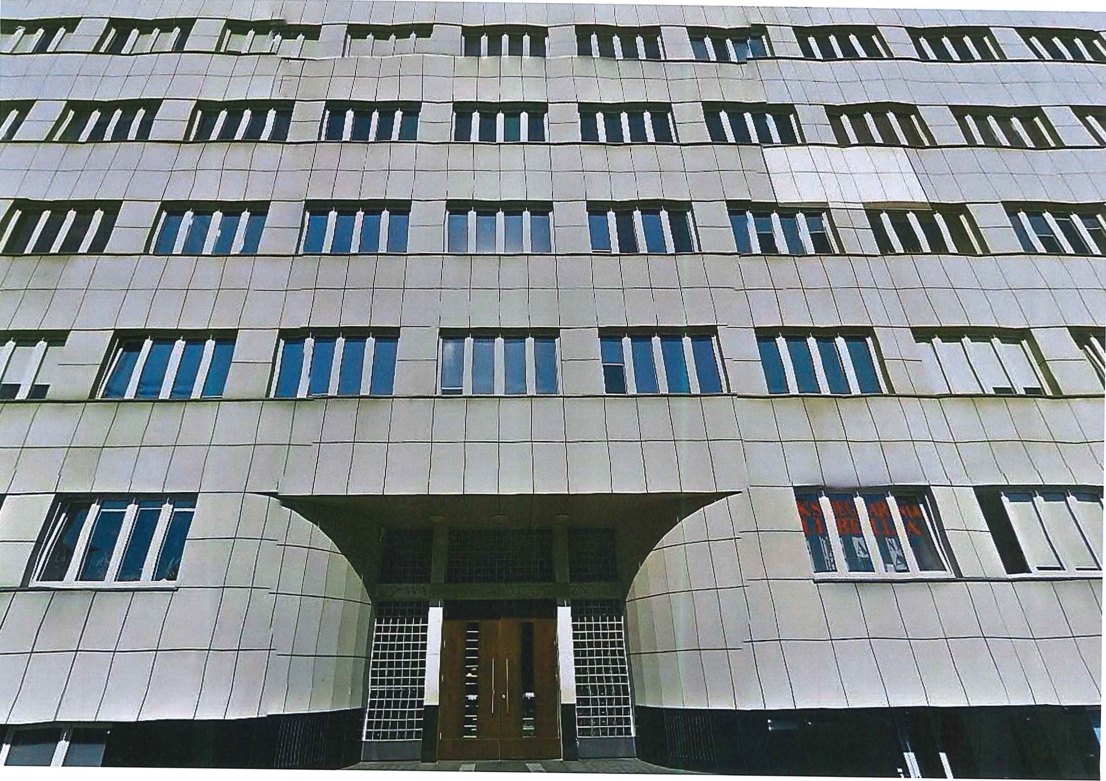
Budynek przy Placu Sejmu Śląskiego 1, widok na wejście do budynku
