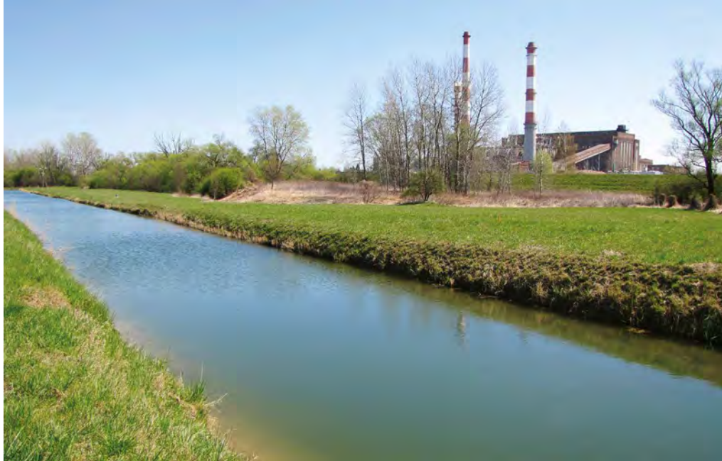
Dodatkowe zasilanie wód podziemnych wodą z Dunajca za pomocą rowu infiltracyjnego w Tarnowie / fot. Grzegorz Wojtal
