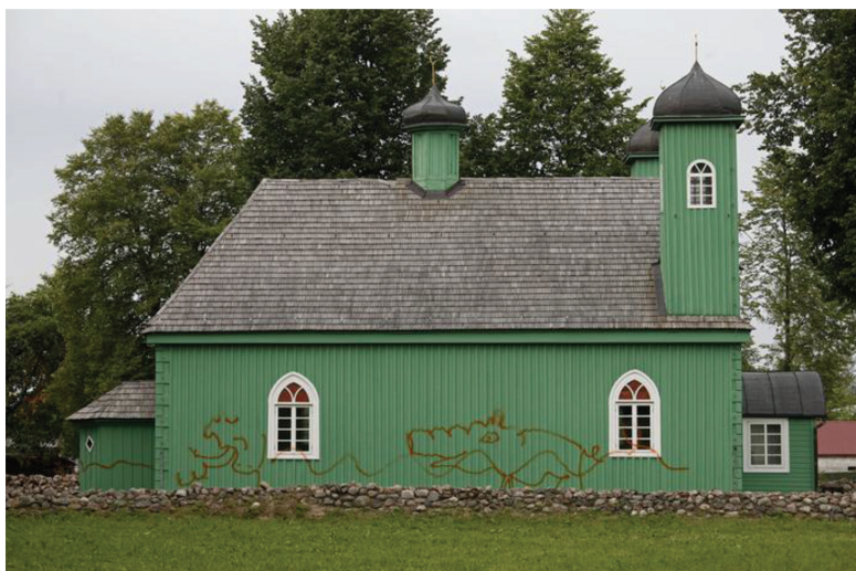
Fot. 1. Zdewastowana ściana meczetu w Kruszynianach
